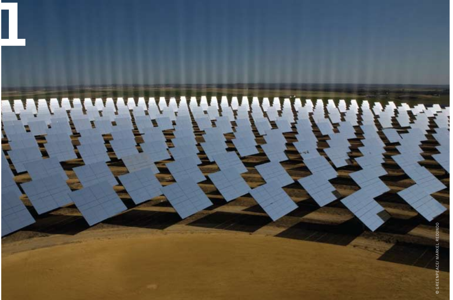
imagem USINA SOLAR EM SEVILHA, ESPANHA. A INSTALAÇÃO TEM CAPACIDADE PARA GERAR ELETRICIDADE PARA MAIS DE 6 MIL RESIDÊNCIAS.
