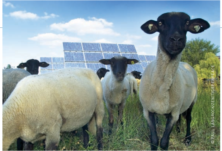
imagem INSTALAÇÃO FOTOVOLTAICA PRÓXIMA A BERLIM, ALEMANHA.
