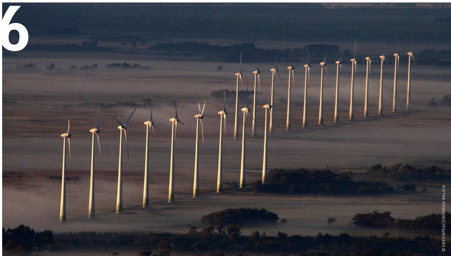
imagem PARQUE EÓLICO DE OSÓRIO, RIO GRANDE DO SUL. INSTALAÇÕES COMO ESSA ATRAEM NOVOS INVESTIMENTOS, AQUECEM A ECONOMIA LOCAL E GERAM NOVOS EMPREGOS.
